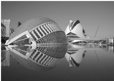
Resim 4. Calatrava, Valencia Bilim ve Sanat Kompleksi,1996
